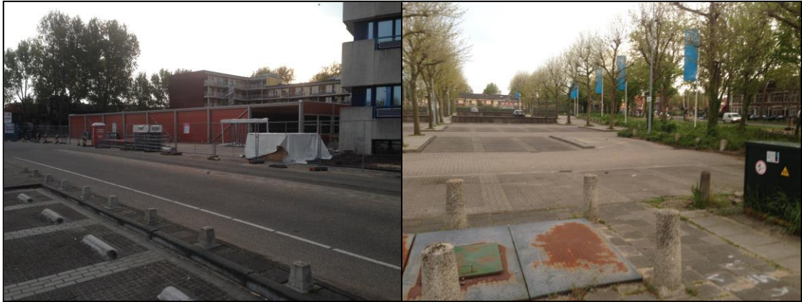
Figuur 5. Een overzicht van de situatie in het plangebied. De linkerfoto betreft de bouwplaats van een noodgebouw, waardoor hier geen onderzoek plaats kon vinden. De rechter foto betreft een aanzicht op de noordwestzijde van het plangebied, deelgebied 3.
